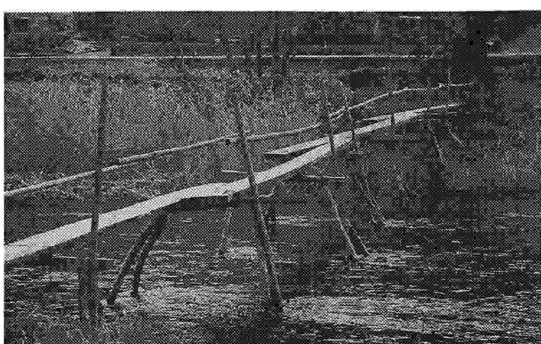
木造の一本橋「松日橋」。台風や大水で流されるたびに橋かけ作業をするのに
